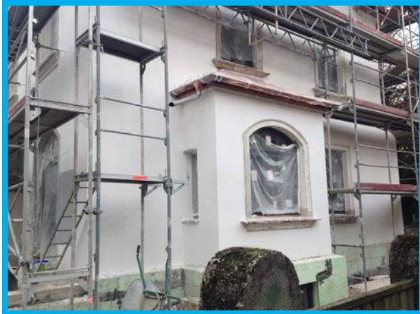
Grundierung des mineralischen Untergrundes
